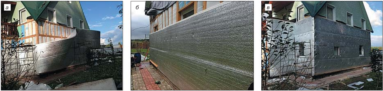
Рис. 1. Теплоизоляция коттеджа: а – разворачивание рулона НПЭ; б – закрепление теплоизоляции и шивка полотен НПЭ; в – формирование изоляционного контура и оконных проемов
